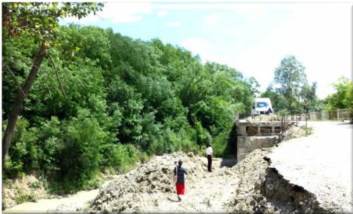
Pod din Lacul lui Baban surpat în urma inundațiilor din 2012 (foto: AlmaConsulting)
