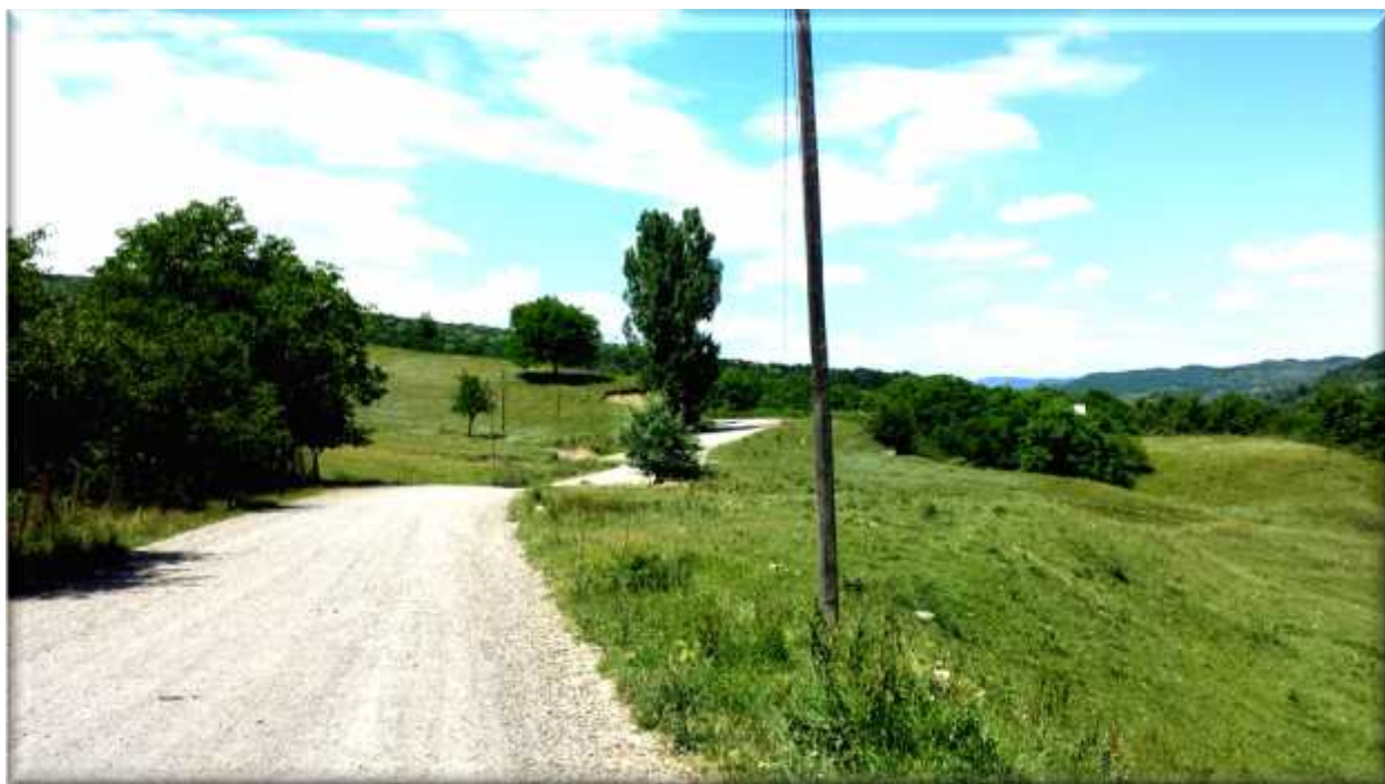
Drumul principal din Gura Caliiței (foto: AlmaConsulting)
